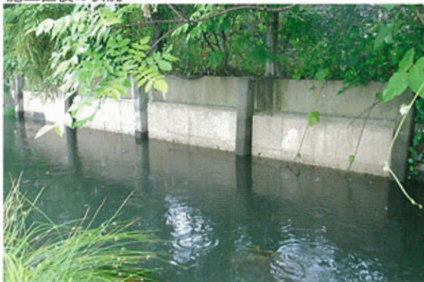
施工直後の状況
