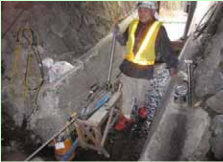
水路奥の巻き取り機械でワイヤーを引きボックスカルバートを 横引きしました。L=17m 最小隙間5mmで施工
