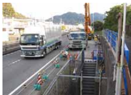
国道一号線直下の水路更生
