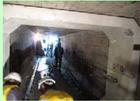
水路奥の巻き取り機械でワイヤーを引きボックスカルバートを 横引きしました。L=17m 最小隙間5mmで施工
