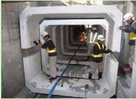
上下ブロックの組み立て状況
