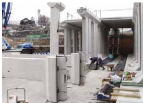
ブロックの据付作業状況
