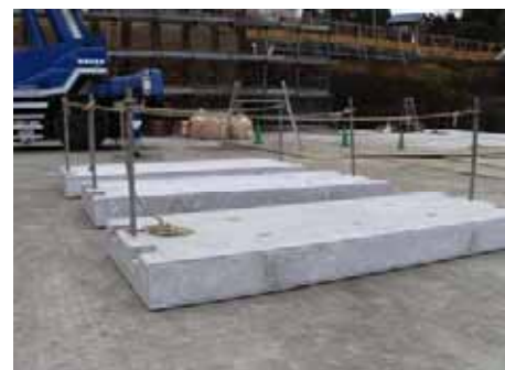
頂版スラブ。転落防止柵を立てる
