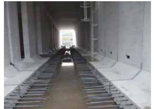
現場打ち前の鉄筋組み作業
