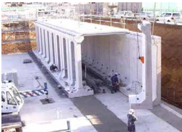
製品の吊り下し作業状況
