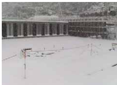
施工中になんと雪が降りました
