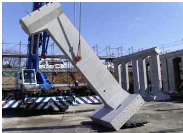
スタンドブロックの引き起こし作業状況
