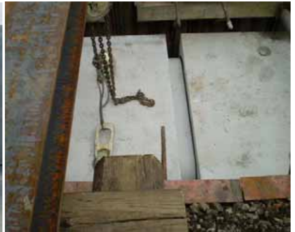
▲ ゴムリングが回転し接続されるMMSボックスカルバート
