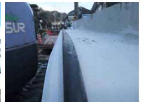
▲ ゴムリングが回転し接続されるMMSボックスカルバート
