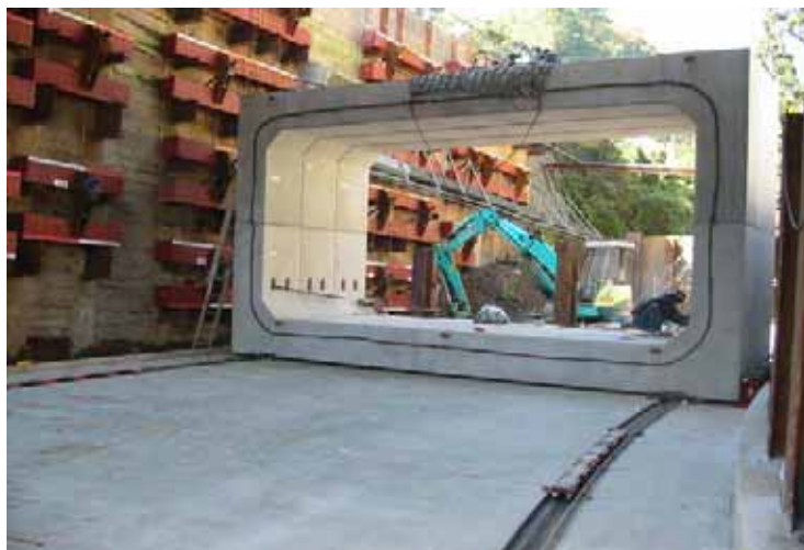
現場は熱海梅園 ボックスカルバート口6500×3200×895
