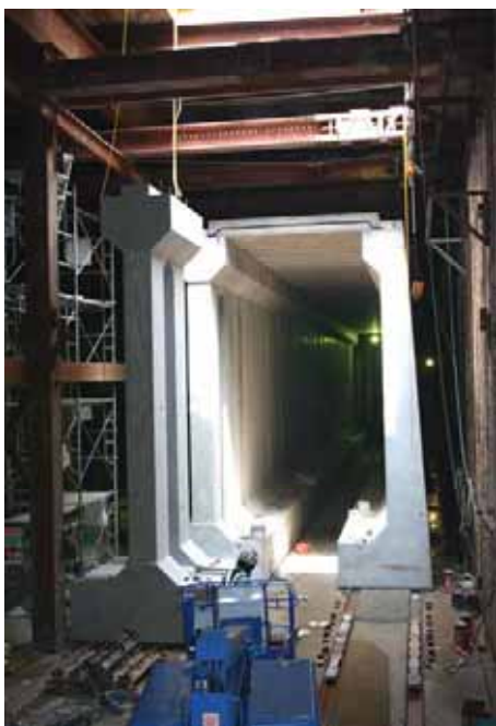
左 遊水地ブロックH5500 スラブW5000を3リング連結してスライド。 重量約85トン。現部は日比谷交差点直下。
