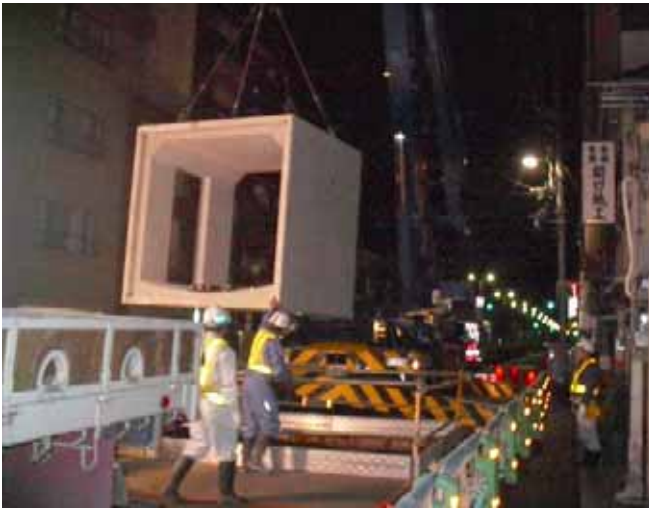
▲ ブロックの搬入(下水道幹線の一部に縦坑を設置)
