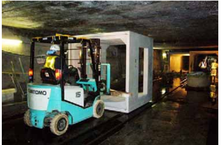
▲ ブロックの押し込み搬送(電動フォークリフトにて)
