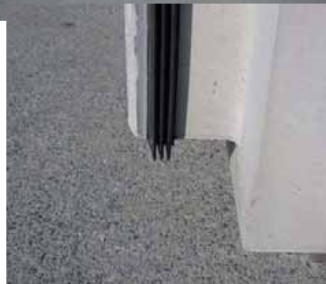
▲ オスリングに耐震ゴム輪ジョイント付の 「IBボックスカルバート」
