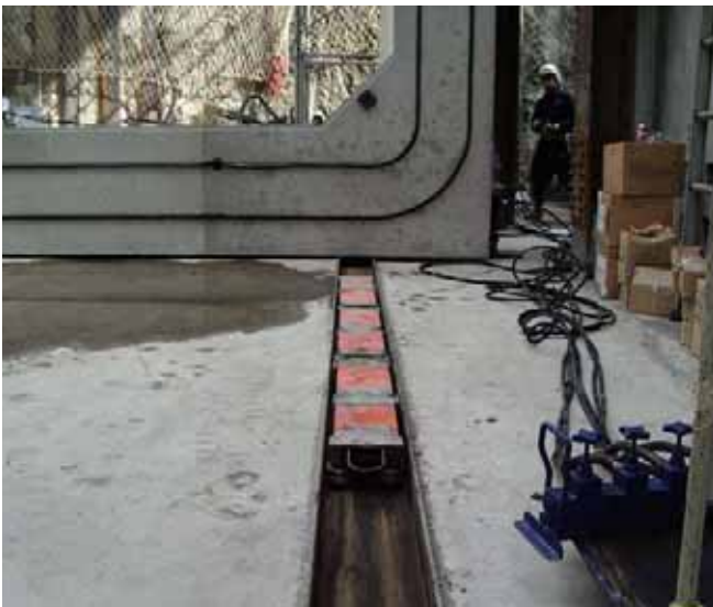
▲ チルタンクにボックスカルバートを乗せて横引き
